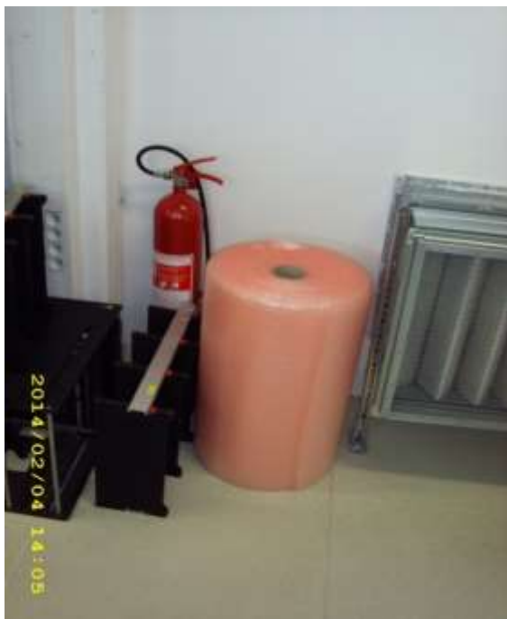
Obrázek 9 - Příklad zastavěného hasicího přístroje.
