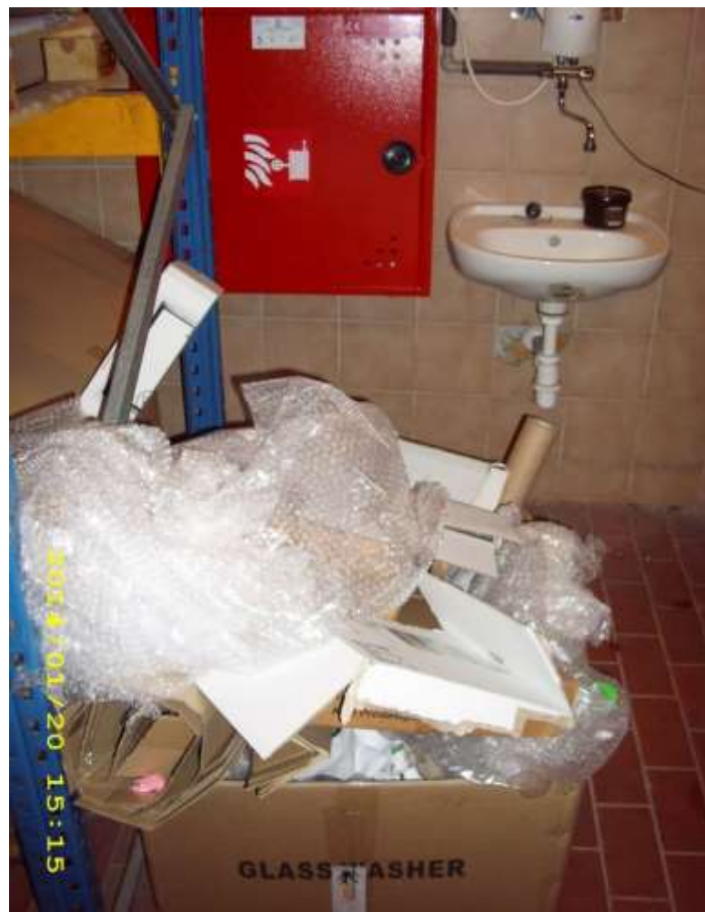
Obrázek 3 - Zastavěný přístup k hydrantu.
